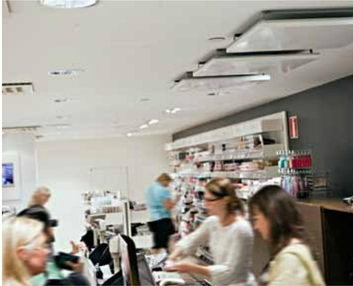
Локально добавить тепла в рабочую зону удобно с помощью потолочных кассет.
