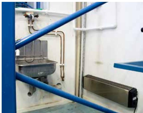
Имеется коррозионно-стойкое исполнение Thermowarm для помещений с повышенной влажностью.
