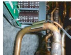
Remove the Thermistor(Discharge).
